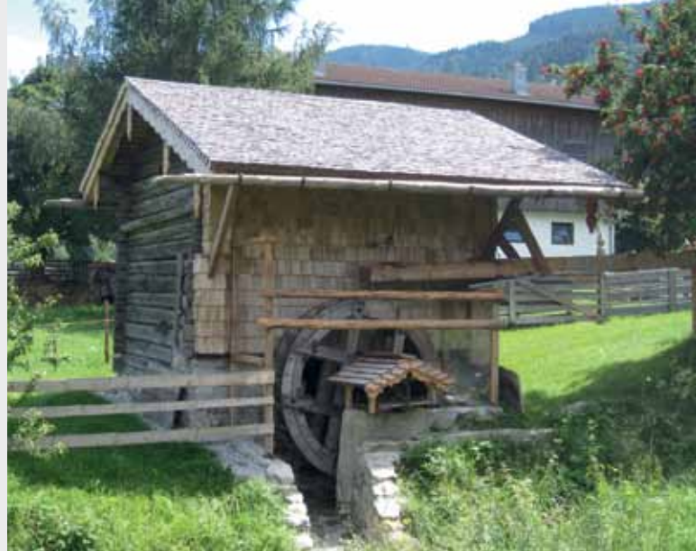
Gelungene Gesamtsanierung in Eigenregie: Kalchschmiedmühle in Bruck/Glstr (1853)
