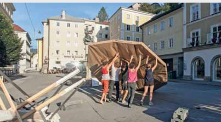
Studierende aus dem Kurs „Public Space“ von feld72 errichten ihre temporäre Skulptur auf dem Kajetanerplatz (Foto: Pia Streicher).
