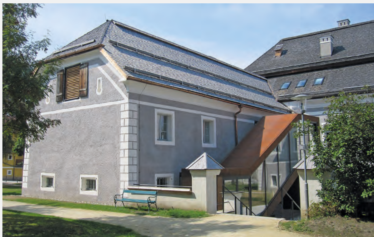
Das Schloss Kuenburg in Tamsweg nach der Sanierung mit modernem Seitenaufgang. Fotos: Christian Haller
