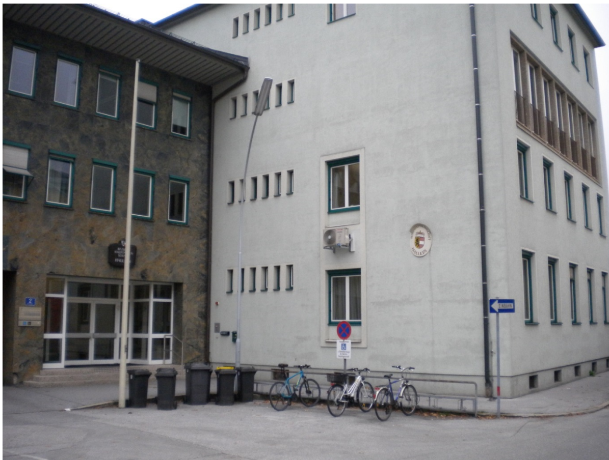
Abbildung 2: Ansicht Bestandsgebäude BH Hallein Haupteingang 2015
