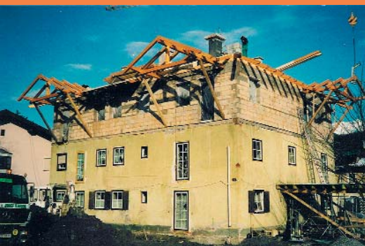
Sanierungen sind komplexe Aufgabenstellungen mit vielen Beteiligten.
