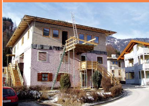
Seit Februar 2004 hat dieses Haus ein Stockwerk mehr.
