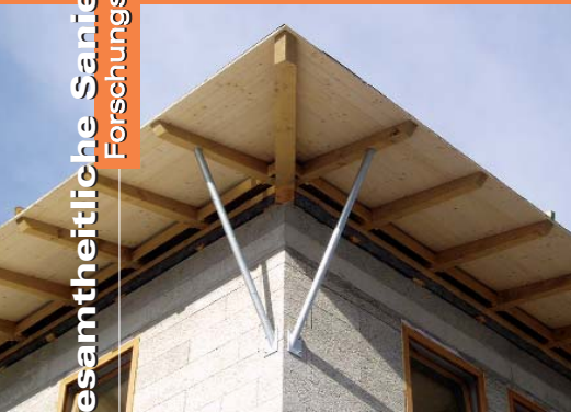
Detail vom neuen Dach bei den aufgestockten Häusern
