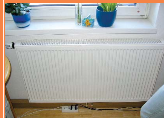
Nachträgliche Installation ist meist im Bereich der Sockelleisten möglich.
