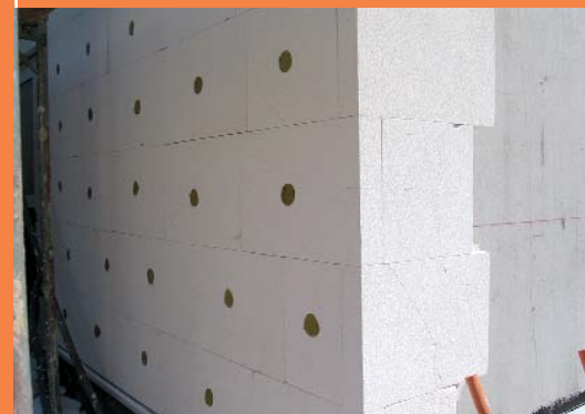
Mineralschaumdämmplatten: ökologisch, einfach zu montieren und nicht brennbar
