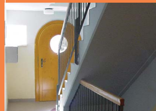
Nachher: Helle, freundliche Stiegenhäuser schaffen einen schönen ersten Eindruck und ein Gefühl von Sicherheit
