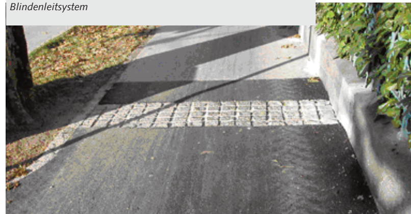
Hochwasserschutzmauer Giselakai Blindenleitsystem
