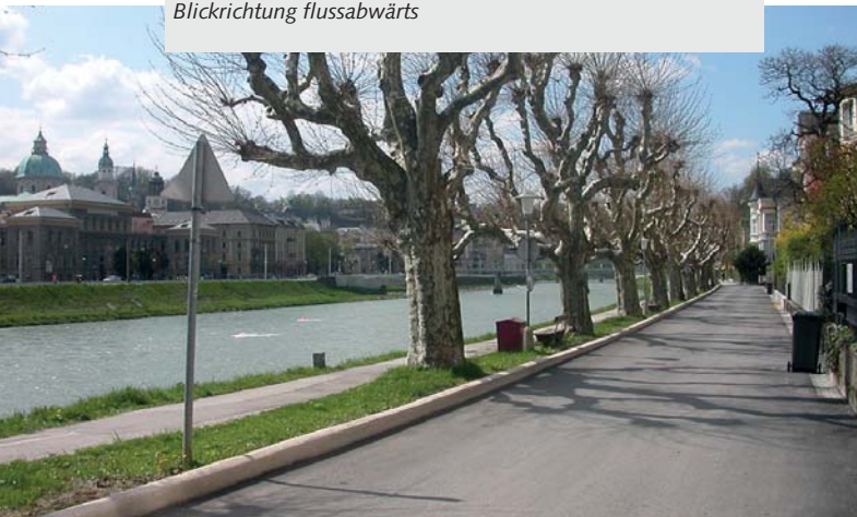
Hochwasserschutzmauer Giselakai Blickrichtung flussabwärts
