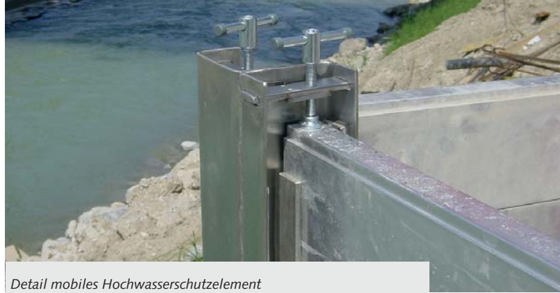
Detail mobiles Hochwasserschutzelement
