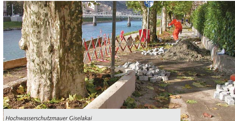
Hochwasserschutzmauer Giselakai Blickrichtung flussabwärts
