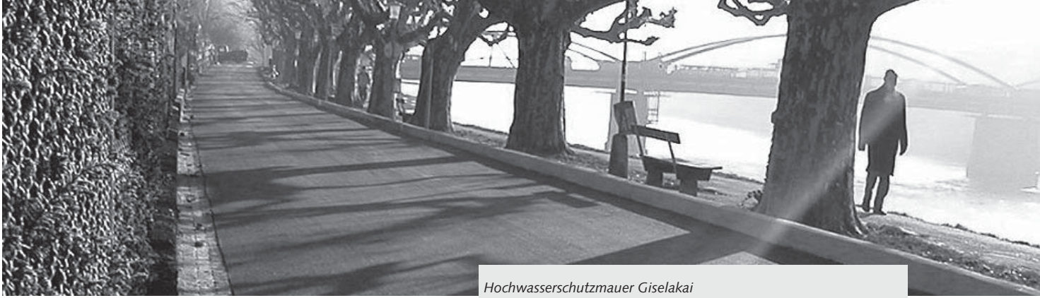
Hochwasserschutzmauer Giselakai Blickrichtung Nonntaler Brücke
