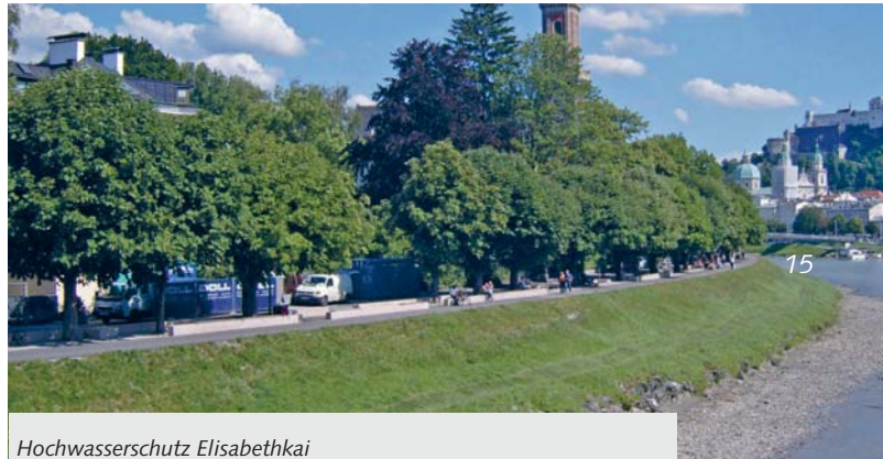
Hochwasserschutz Elisabethkai Blickrichtung Altstadt
