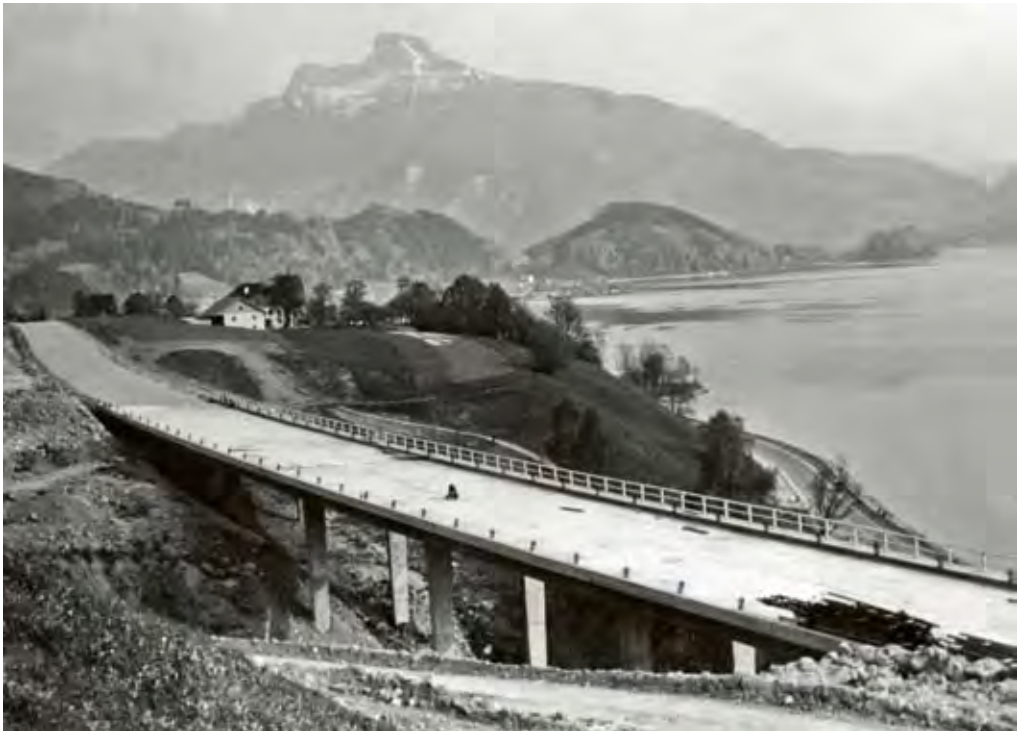
Bau der Westautobahn bei Mondsee, Mai 1963 (SLA, Fotosammlung C 014763)
