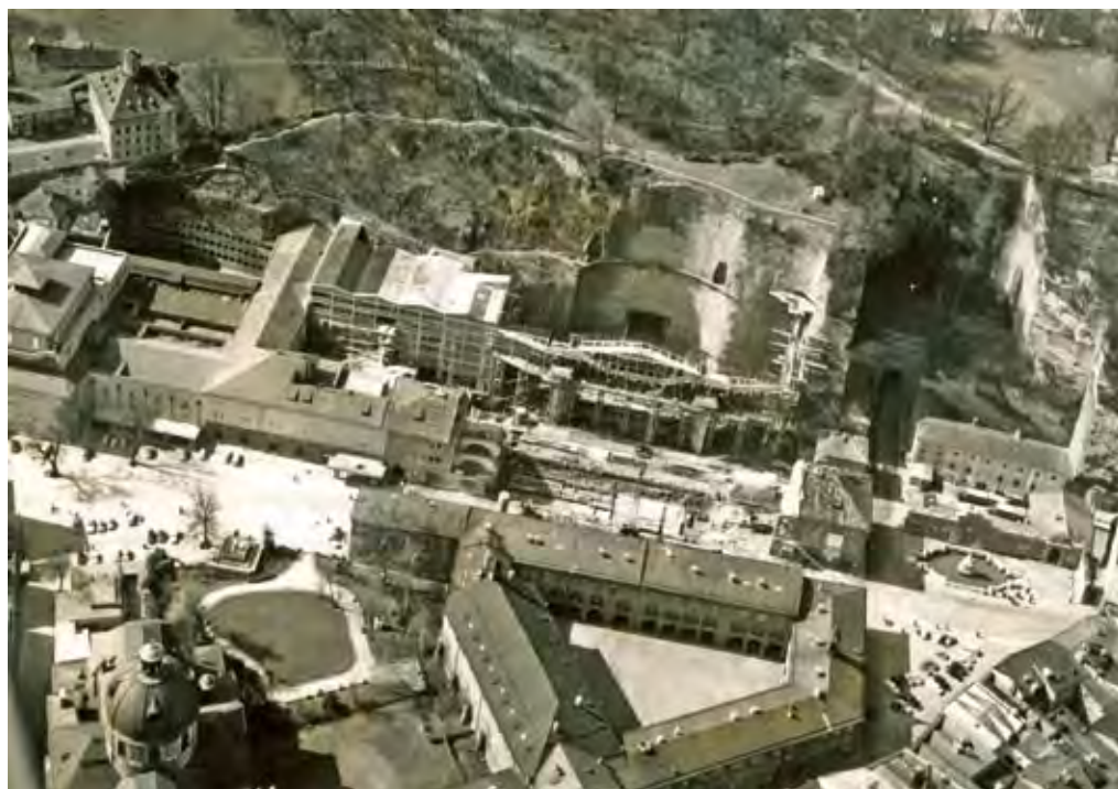
Bauzustand des Neuen Festspielhauses 1958 (SLA, Fotosammlung C 020509)
