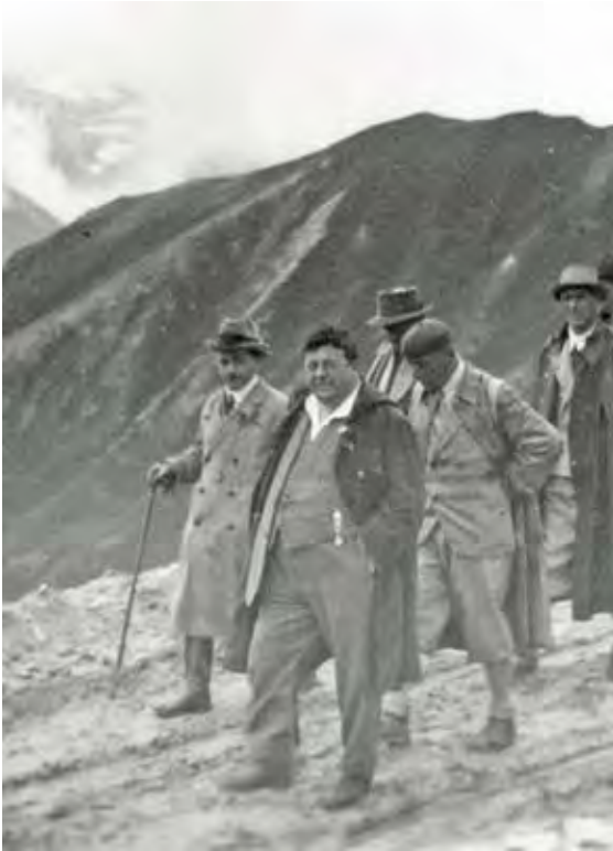
Landeshauptmann Rehr und Bundeskanzler Dollfuß beim Besuch der Baustelle der Großglockner-Hochalpenstraße am 15. Juli 1934 (SLA, Fotosammlung A 030954)
